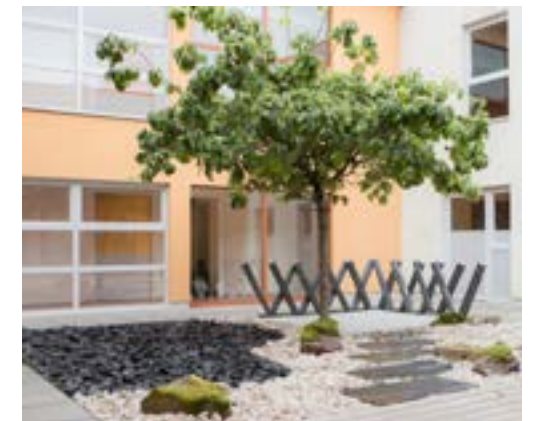
Travaux d'aménagement extérieur aux Jardins du Clos
